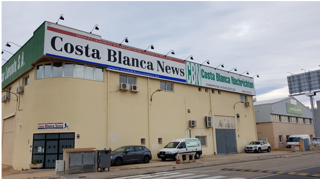
Bild 1: Das Verlagsgebäude in Finestrat von außen. Dort befinden sich u.a. die Redaktion der Costa Blanca Nachrichten und die Werbe- und Anzeigenabteilung.
