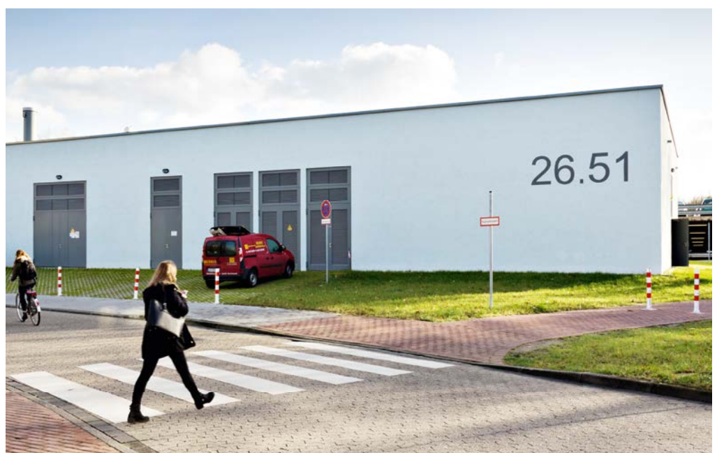
► Die Technikzentrale 2 im Campus-Südbereich. Insgesamt 48 Abzweigungen leiten den Strom von den beiden Technikzentralen 1 (Gebäude 21.01) und TZ 2 (Gebäude 26.51) zu den Transformatoren auf dem Campus. (Foto: Ellen Barbara Reitz)
